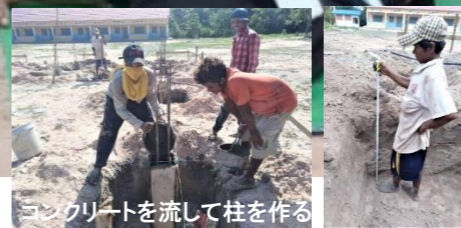
柱の土台の穴の深さを測る
